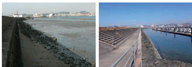
施工前 施工後
