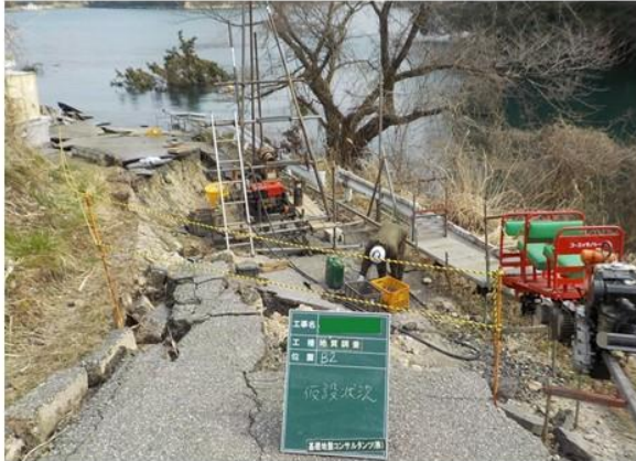
被災地におけるボーリング調査(基礎地盤C)
