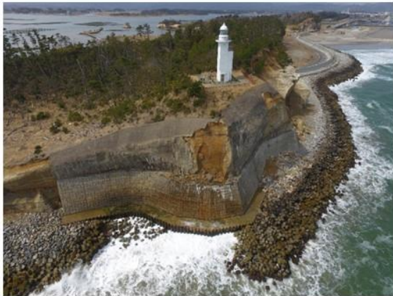
崩壊した法面
