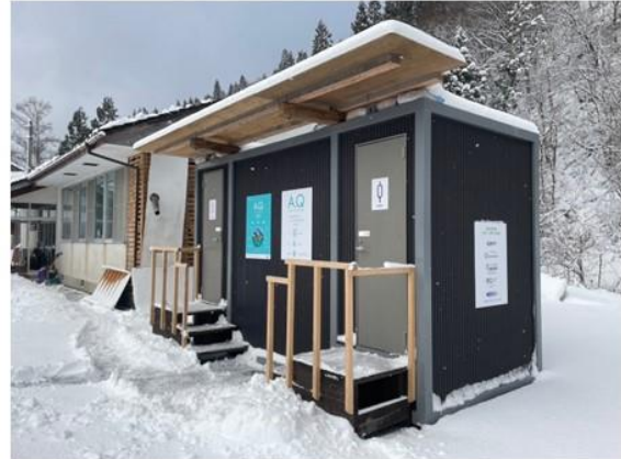
能登町の避難所に設置したA.Qトイレ(長大)
