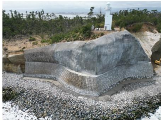
対策施工が完了した法面
