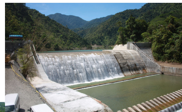
アシガ川 小水力発電所
