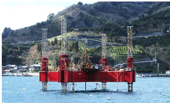
洋上風力発電施設の地盤調査
