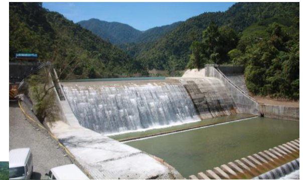
アシガ川 小水力発電所
